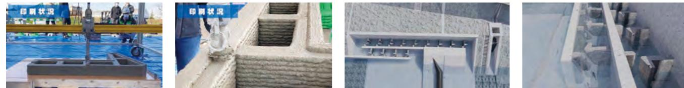
河川堰工事において魚道に設置する13組の隔壁を3Dプリンターで製作。
